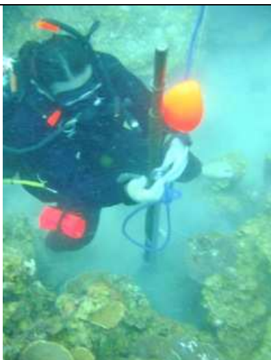
Instalación de Barras de hierro.
