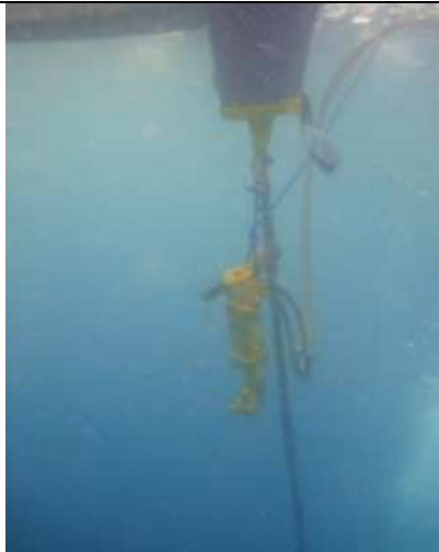
Levantamiento de martillo y varillas.
